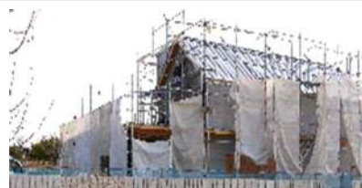
建設中のベーカリー
